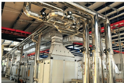
Tầng kỹ thuật (nhà máy BETA-LACTAM) - Hệ thống xử lý khí đảm bảo độ chênh áp giữa các khu vực sản xuất
