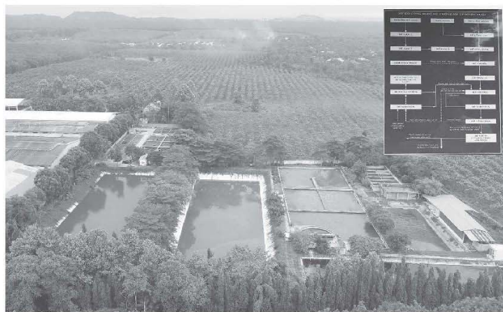
Toàn cảnh hệ thống xử lý nước thải
