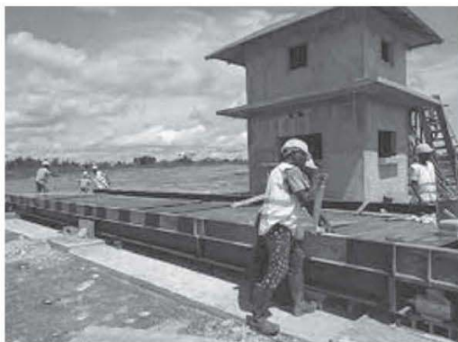
Nhà máy đang được xây dựng.
