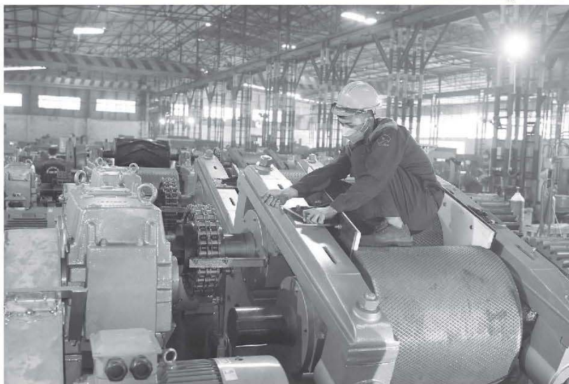
Công nhân lắp đặt máy cán mũ từ 5 cặp trục cho đối tác
