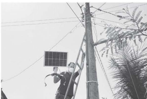
ĐTN Cao su Tân Biên đã phối hợp với Huyện đoàn Tân Châu tổ chức lắp đặt đèn chiếu sáng trong chương trình “Thắp sáng đường quê” hưởng ứng hoạt động xây dựng nông thôn mới tại địa phương
