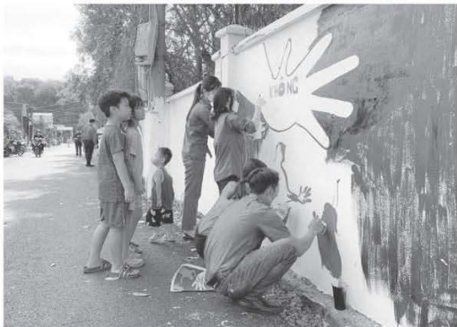
ĐTN Cao su Bà Rịa tiến hành sơn mới tường và vẽ tranh cổ động thực hiện công trình “Tuyến đường Thanh niên kiểu mẫu” tại hẻm Đức Trung, tổ 7, ấp Đức Trung, xã Bình Ba
