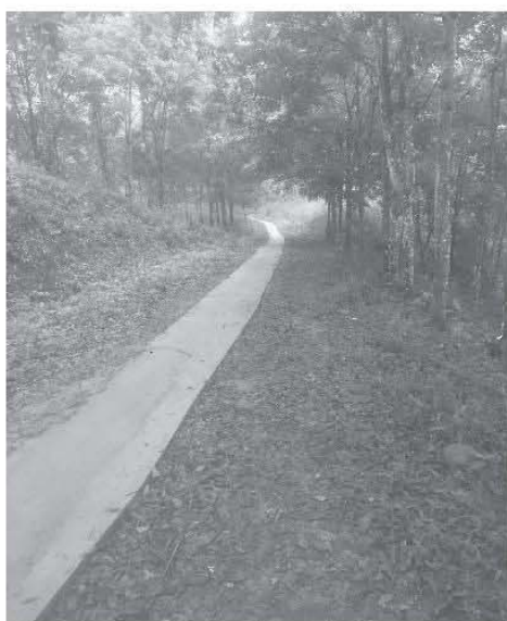
Công ty đã làm được 6km đường bê tông rộng 1m từ chân đồi lên đỉnh đồi để công nhân thuận tiện đi lại. Ảnh: CTV
