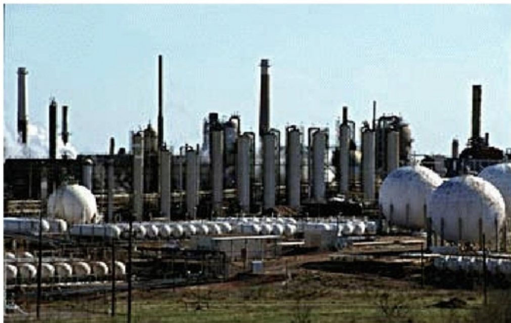
Hình 1.12 a. Một cơ sở lọc hóa dầu của Hãng Phillip (Phillips Petroleum Company) [16]
