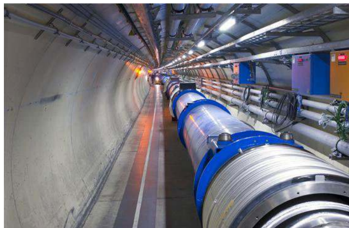
Đường dẫn chùm hạt LHC. Cho proton va chạm với chì là khó vì cả hai chùm hạt được lái bởi những nam châm giống nhau. (Ảnh: CERN)
