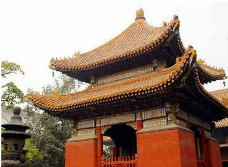
Ung hòa cung Bắc Kinh
