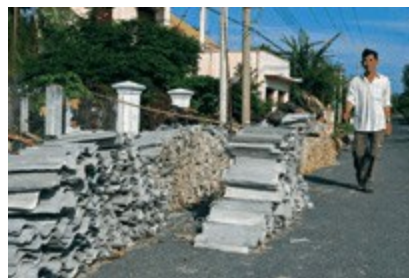
Tôn xi măng hư bể được tận
